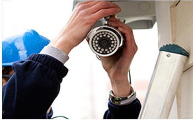
Instalación de cámaras de seguridad CCTV
